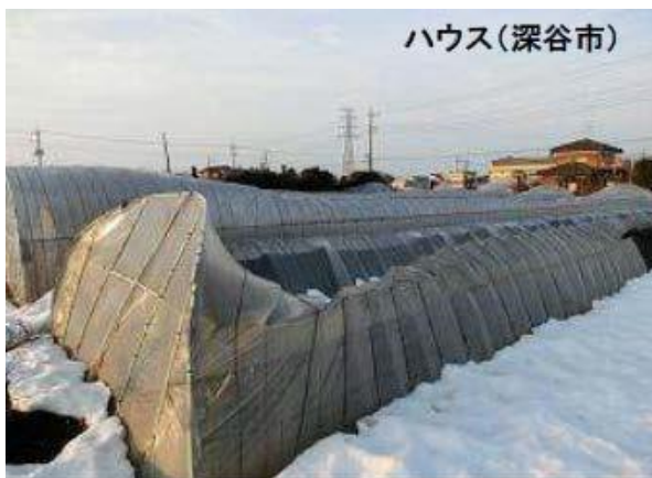
ビニールハウスの被害
